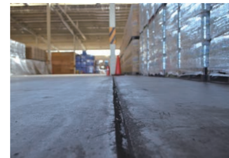
段差が修正され、フラットな状態に
