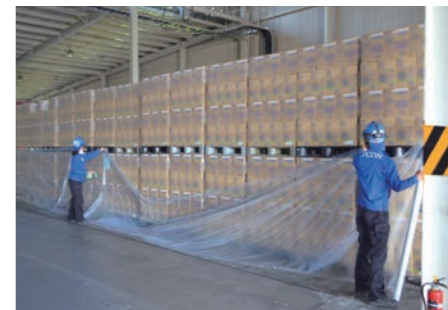
荷物を移動させずに施工(養生徹底)
