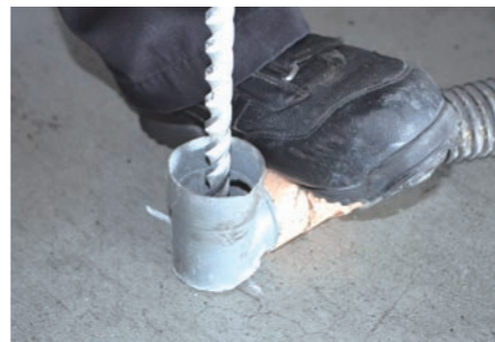
集塵機は実用新案登録済み。削孔時に埃が殆ど発生しません
