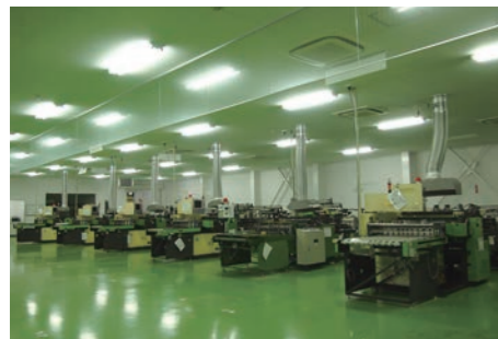
地盤沈下により、機械に傾きが発生
