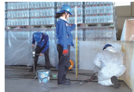
ウレタン樹脂注入(ミリ単位でレベル管理)
