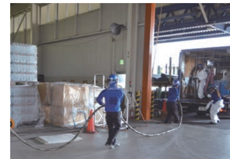
ウレタン樹脂注入用ホース搬入(最大延長80m)
