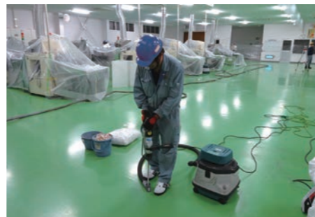
削孔の様子(集塵機を使用し削孔します)
