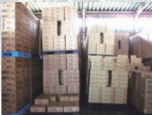
床がたわんでしまったことでパレットが傾き倉庫内の荷物が傾いている
