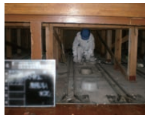
ステージ下でのウレタン樹脂注入
