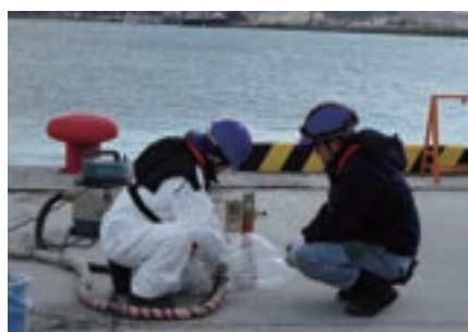
港湾荷降ろし岸壁に出来た水勾配の復旧
