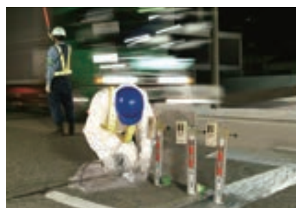
供用を停止せず施工が可能
