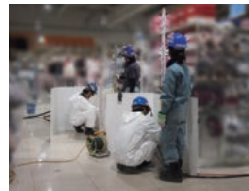
閉店後、翌日営業までの時間で夜間施工が可能
