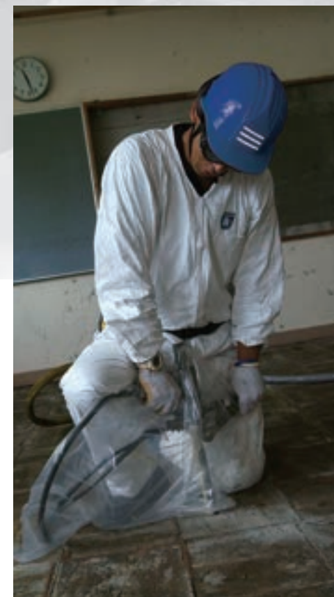
たわんだ床の沈下修正は一般的な教室の広さなら1日で施工が可能
