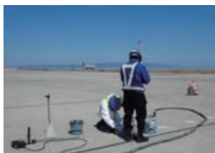
空港の段差修正
