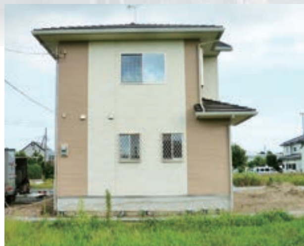
沈下量が大きかったため、単管杭圧入工法を併用
