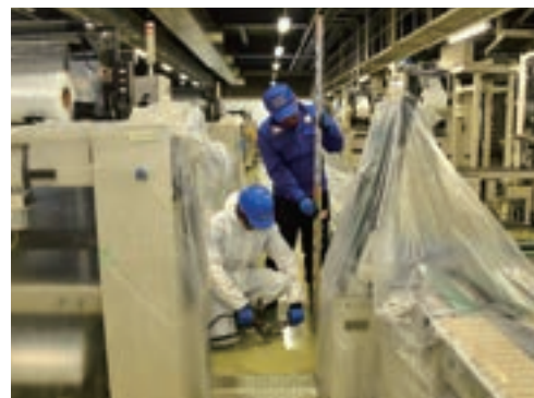
機械など、移動せずに施工が可能
