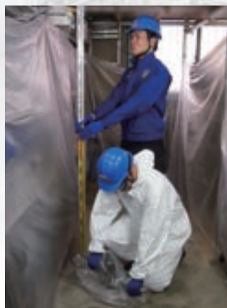
ミリ単位で制御しながら沈下修正をおこなう
