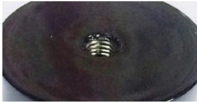
摺動面に塗装を行うと、摩擦によって塗装が剥がれてしまうので、摺動面にはマスキングをして塗料がかからないようにしなければなりません。
