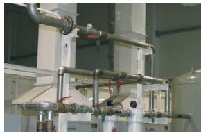
エア配管工事
