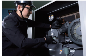
コンプレッサーの修理対応
