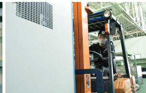
搬入設置工事
