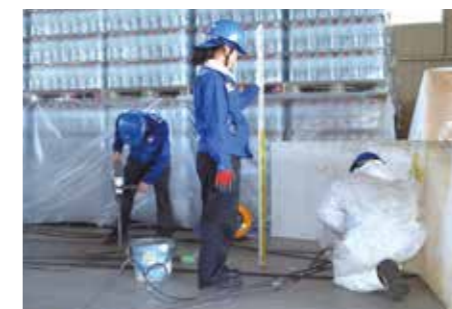
ウレタン樹脂注入(ミリ単位でレベル管理)
