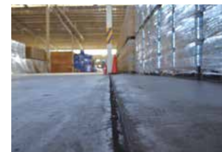
段差が修正され、フラットな状態に
