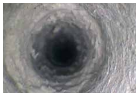
施工後はウレタン樹脂が密に充填されている
