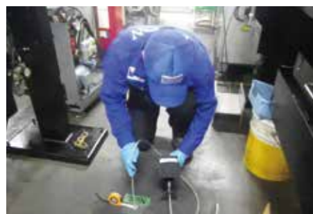
CCDカメラを使用し空隙の充填を確認
