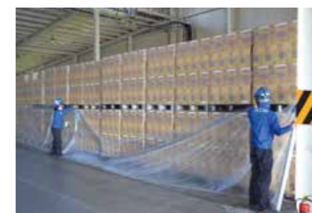
荷物を移動させずに施工(養生徹底)
