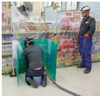
店舗での施工の様子
