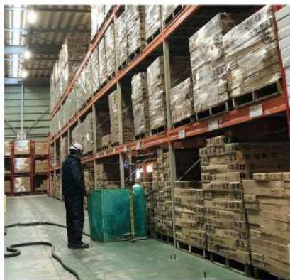
物流倉庫での施工の様子
