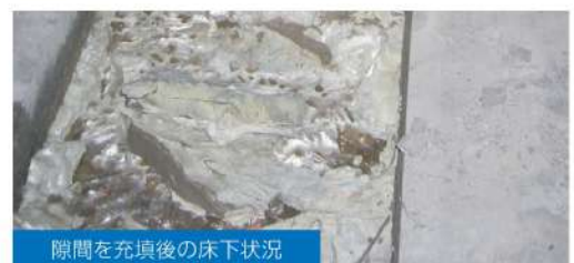
隙間を充填後の床下状況
